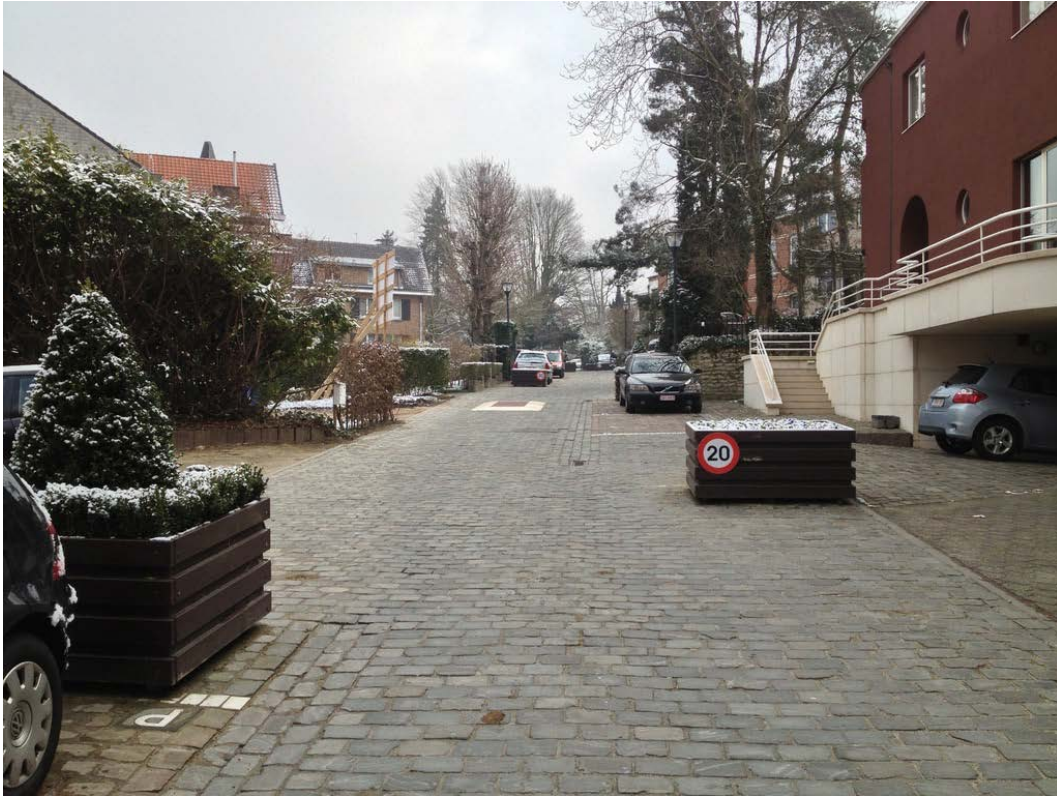
Joonis 12. Kohaliku tänava näide Brüsselist. Autoliiklust rahustavate elementidena kasutuses parkivad autod, haljastuse kastid, speed cushion tüüpi künnis.
