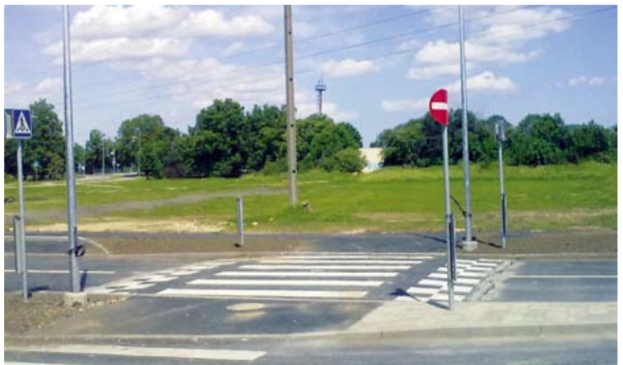
Jüri gümnaasiumi ees olev Taaramäe tänav on üks sellel suvel valminud valla ehitusobjektidest.
